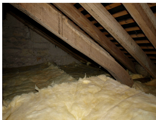
Isolation sous la toiture
