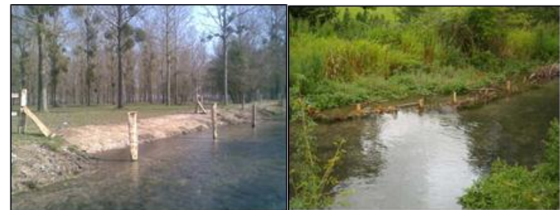
Figure 24 : tressage de saule et abreuvoir stabilisé au niveau de la commune de Guizancourt.
