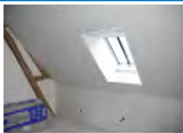
APRES : pièce refaite, nouvelle isolation et nouveau parement. L'espace chauve-souris est compris à l'intérieur
