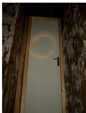
Pose d'une porte pour compartimenter les combles du reste de la MF
